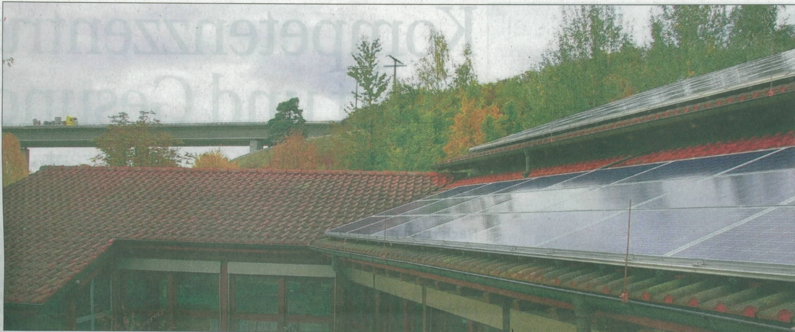
Auf der Mühlbachhalle ist die Photovoltaikanlage dank Investor Uli Kuhn fertig. Ob es möglich sein könnte, auch an der Autobahnbrücke Solarzellen, die als Schallschutzwand dienen, zu installieren, macht man sich derweil in Sulz noch Gedanken. Bild: hz
