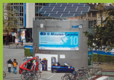
Solartankstelle in Frankfurt/Main
